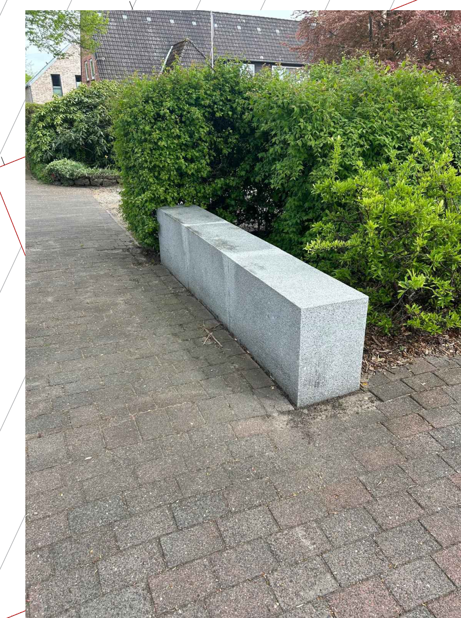
Sitzmauer aus Granit
