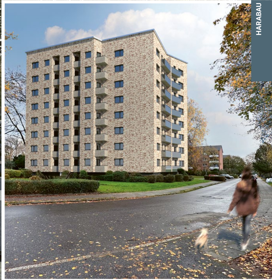
Verjüngungskur: Ab April wird das Wohngebäude von außen und innen modernisiert. Auch die Außenanlagen und Zuwege werden neu gestaltet.
